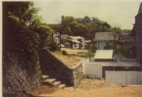
↑ 裏道が整備される前の建物敷地の裏側
