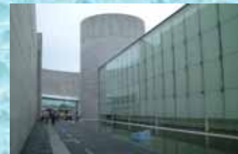
那須野が原 ハニースポール 設計: 早草睦恵 セルスペース 栃木県大田原市本町
