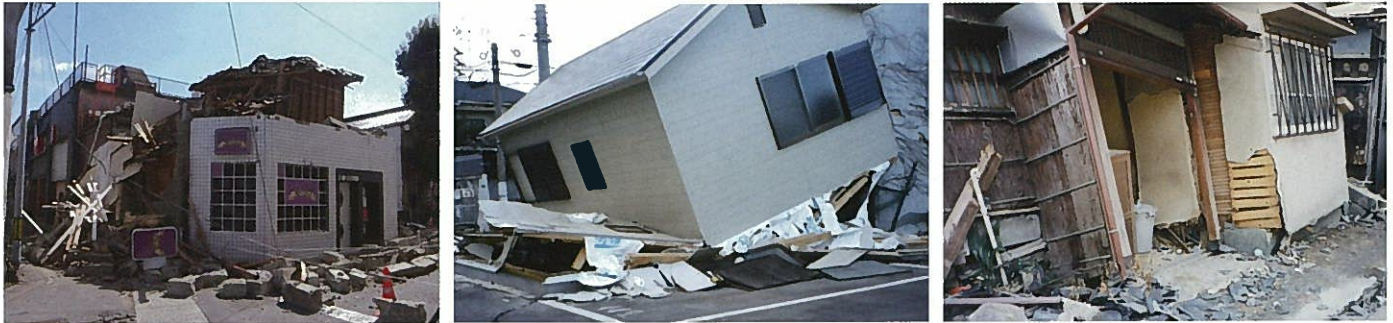
—耐震壁の量やバランス、部材の接合部、基礎部等に弱点のある住宅は大きな被害を受けています。家具等の転倒も被害を拡大させています—
