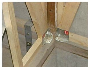
<接合部の補強事例>
