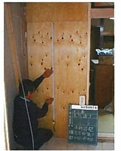
<壁の補強事例> 耐震壁の追加(配置バランスへの配慮)
