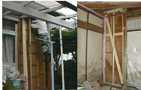
<壁の補強事例> 耐震壁の追加(配置バランスへの配慮)
